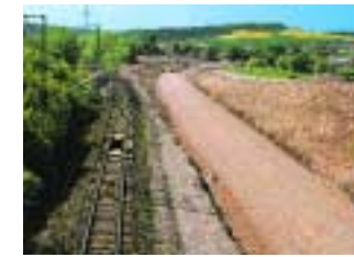
Eichenberger Kurve während der Bauzeit
