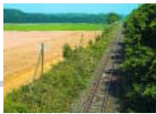
Strecke Uelzen – Langwedel bei Brockhöfe
