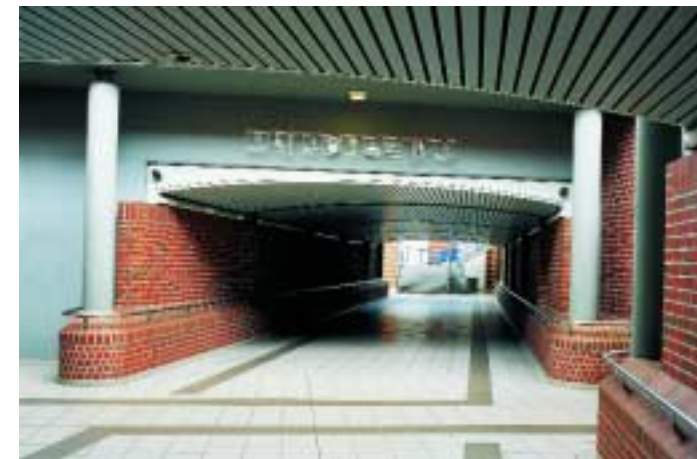
Erschließt Bahnsteige und verbindet Stadtteile: Tunnel in Bad Zwischenahn
