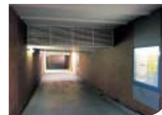
Beim Betreten eines dunklen Tunnels wie in Elze fühlen sich Fahrgäste keineswegs sicher.
