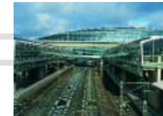
Großzügig und modern: Messebahnhof Laatzen
