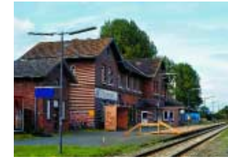
... steht das ehemalige Empfangsgebäude der Kreisstadt Wittmund fast leer und verwaht seit Jahren.
