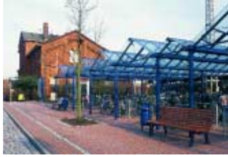
Neue B+R-Anlage in Bassum
