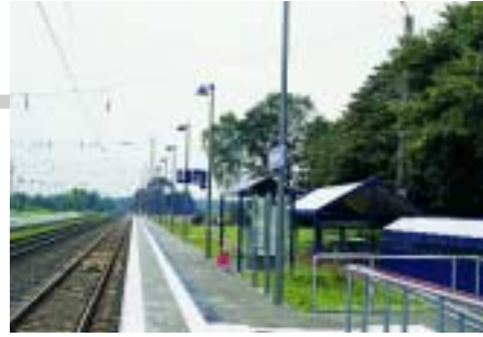
B+R-Anlage im Bereich des Bahnsteigzugangs
