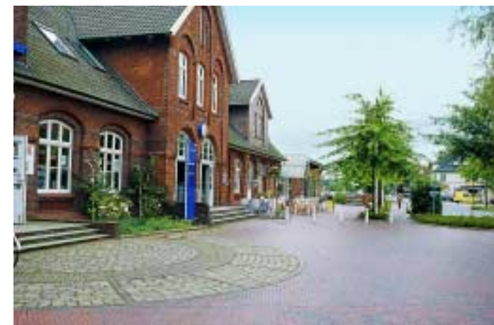
Hat nicht nur „äußere“, sondern auch „innere Werte“: renoviertes Bahnhofsgebäude in Bad Zwischenahn
