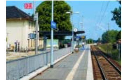
Nach Umbau mit S-Bahn-Standard: neuer Bahnsteig
