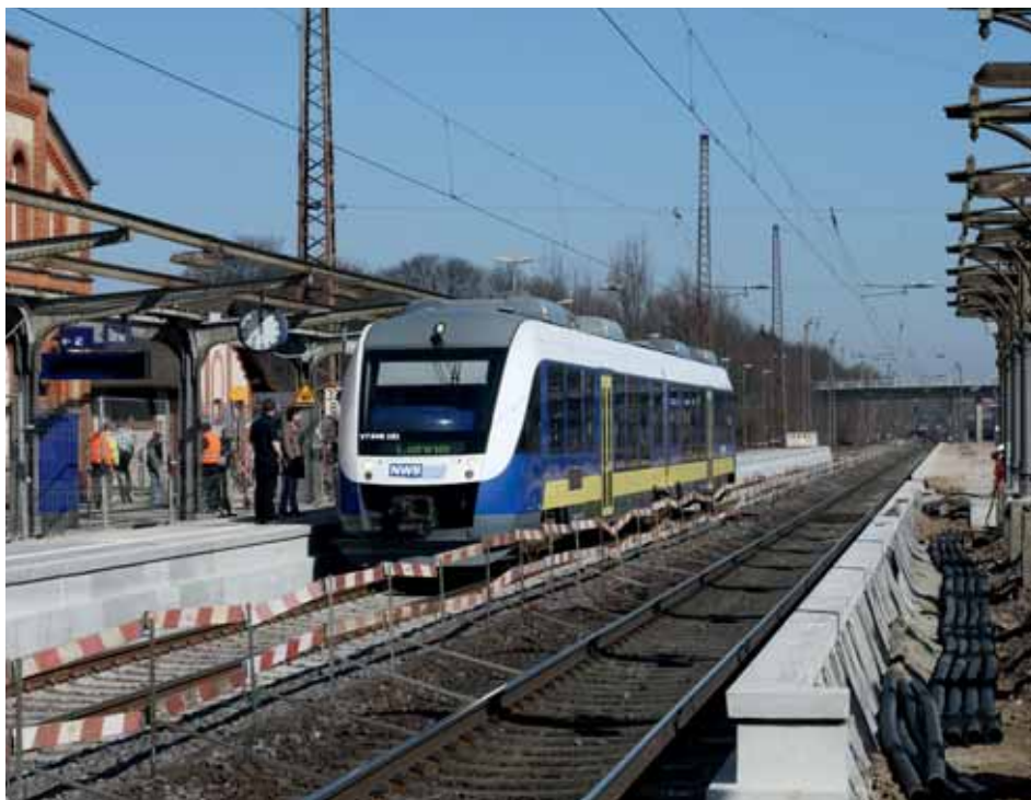
Momentaufnahme vom Bahnhofsumbau in Elze
