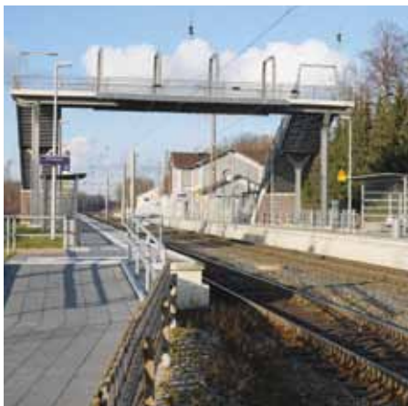
Vor kurzem ausgebaut: Station Banteln
