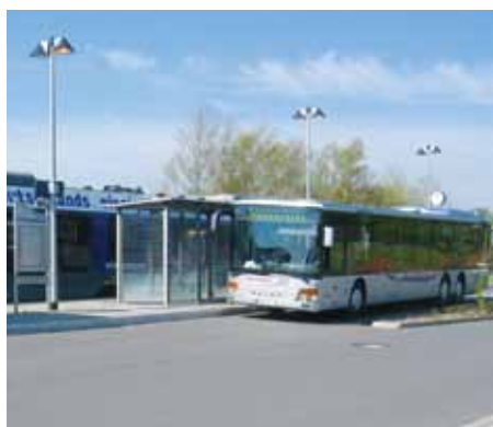
Förderfähig: Verknüpfung zwischen Bus und Zug
