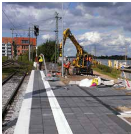
Elsfleth – der Umbau im Raum Bremen (S2 bis S4) läuft
