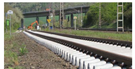
Bauarbeiten zur Reaktivierung der Ilmebahnstrecke in Richtung Einbeck Mitte.
