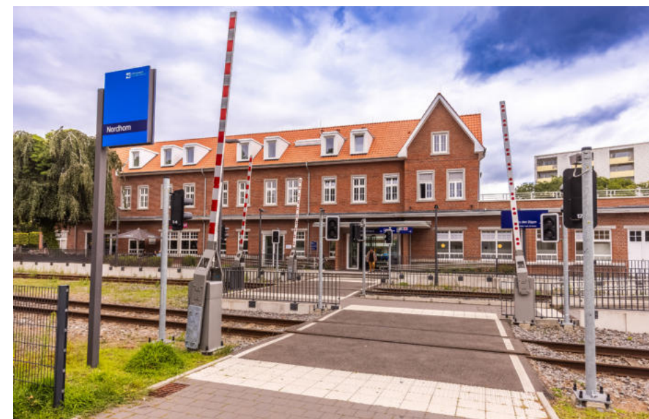
Bahnhof Nordhorn, neues Empfangsgebäude zur Re- aktivierung der RB 56
