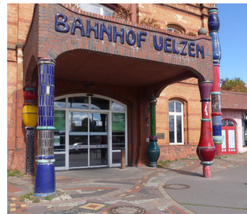
Bahnhof Uelzen, Empfangsgebäude (gestaltet nach den Entwürfen von Friedensreich Hundertwasser)
