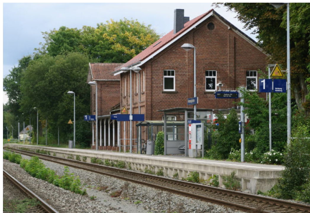
Bahnhof Himmelpforten nach der Modernisierung im Rahmen des Förderprogramms Niedersachsen ist am Zug! II
